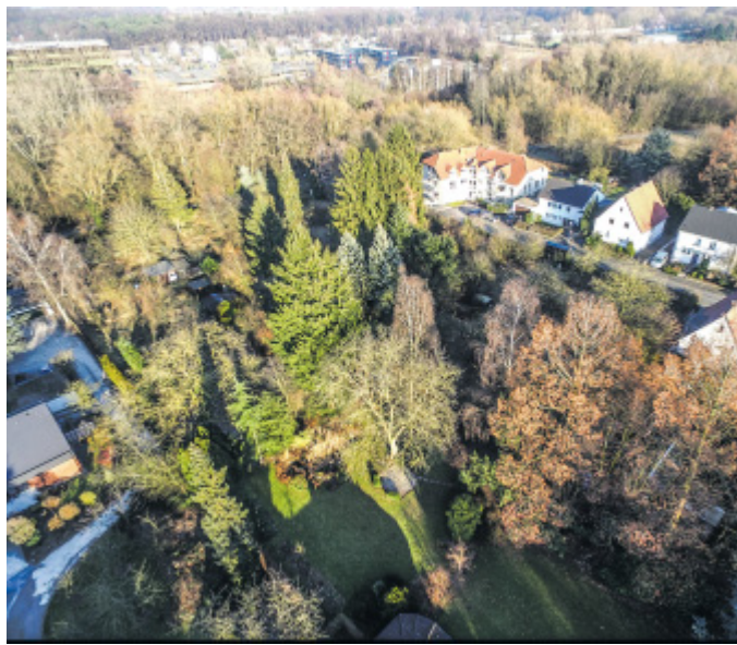
Blick von oben: In der Mitte sind die Kleingärten zu sehen, die Bauplätzen weichen sollen, rechts die Straße „Am Kalberdanz“. FOTO: MK
